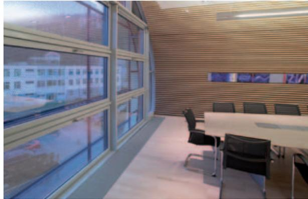
Bild 1: Rechteckiger Bodenquellauslass vor einer Fassade
