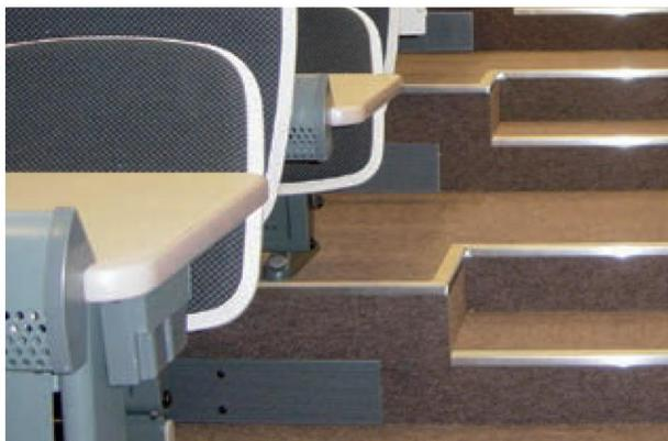
**Bild 10:** Linearer Stufenquellauslass, Kansai Universität, Osaka
