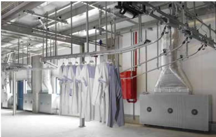
Figure 7: Diffuseurs dans un atelier de nettoyage chimique industriel
