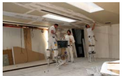
Die Kühldecken von Durrer-Technik werden auf Stelzen verspachtelt
