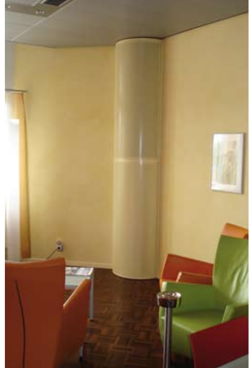
Quellluftdurchlass Q-H-DE... mit integrierter Leitfähigen Luft®
