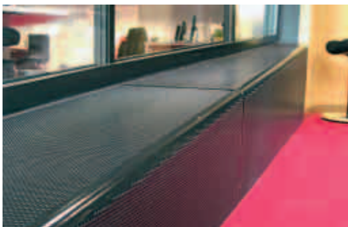
Das Resultat kann sich sehen lassen: Eine ästhetisch ansprechende Lösung, welche auch technisch den hohen Vorgaben entspricht.
