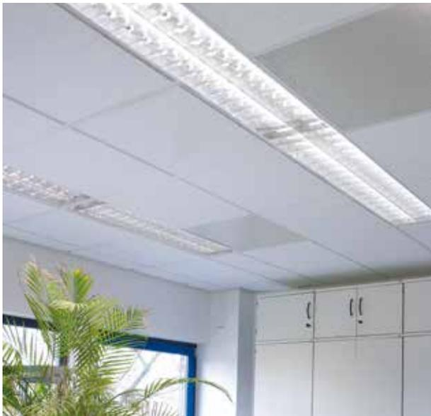
Figure 6: Opticlean incorporé dans un plafond alvéolaire
