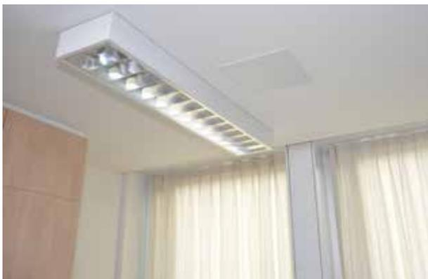
Figure 7: Opticlean incorporé dans un plafond placoplâtre (GK)
