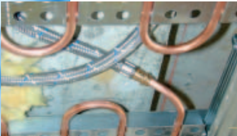
Foto 3: Schlauchanschluss der Kühlelemente mit Pressfitting.
