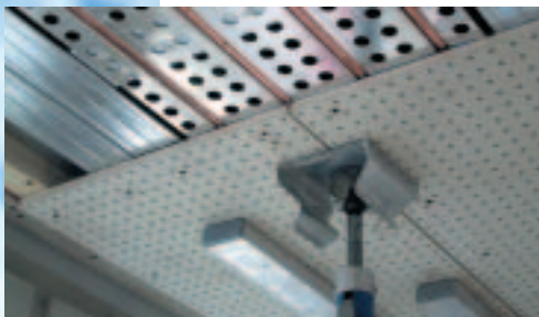
Fotos 4 +5: Verschraubung der gelochten Gipsdeckenplatte.
