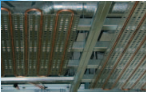
Fotos 1+2: Kühlelemente KKS-2, eingehängt in die Unterkonstruktion der Gipsdecke.
