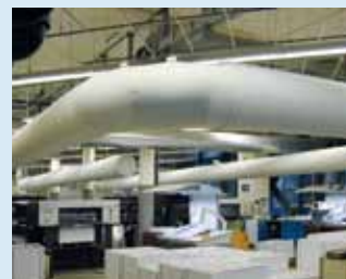
Textilrohre für Industrieanwendungen
