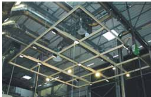
Holzrahmenkonstruktion als Traversenmodell, installierte 16 kW Lichtleistung
