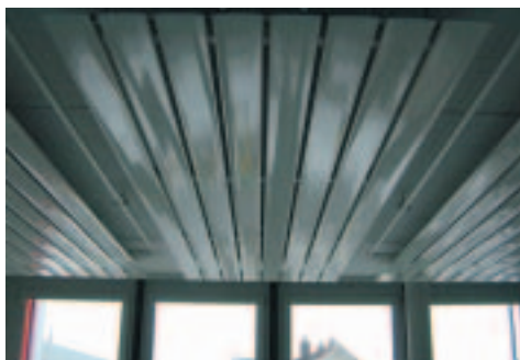
Konvektive Kühldecke SKS-5/3 mit Leistungen von 40 W/m 2 bis 160 W/m 2
